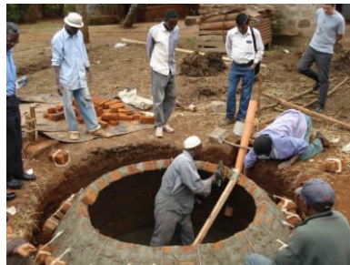
Biogas aus Kuhdung in Kenia
